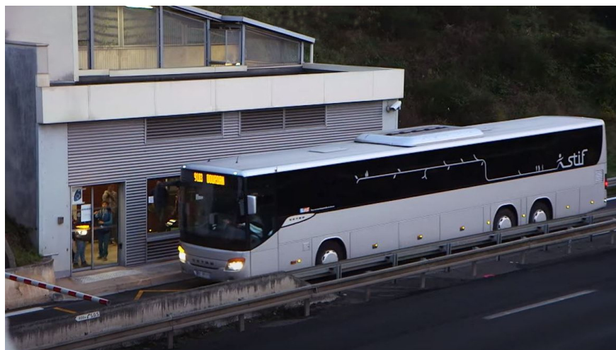
FIGURE 4.1 – Station de car express en Île-de-France : le car ne dévie pas de sa voie principale, il emprunte une voie d'arrêt dédiée pour l'embarquement et le débarquement des passagers. Sur le plan architectural, nul doute que nous pourrions faire preuve d'un peu plus d'élégance.
